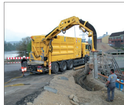
Obr. 2. Odkrývání inženýrských sítí
