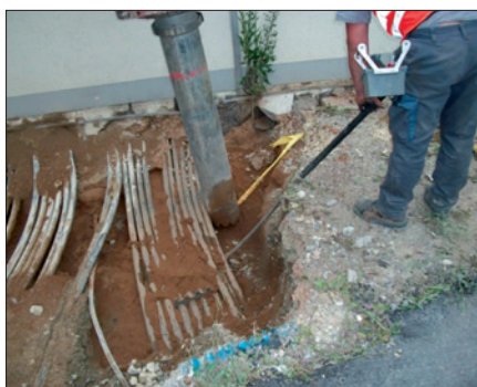
Obr. 1. Odkrývání inženýrských sítí
