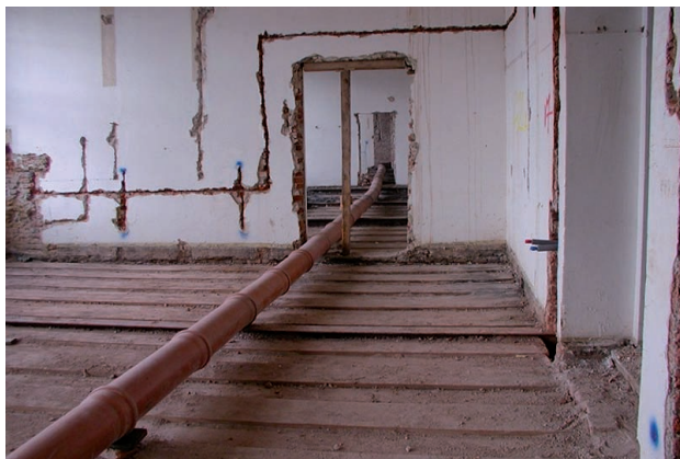
Savice a odsávací potrubí o průměru 25 cm se na staveništi k jednotlivým pracovištím přivádí bud' po lešení, nebo vnitřkem objektu
