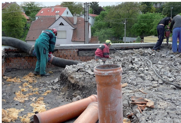
Technologie MTS umožňuje bezprašně odsátí sutě z kteréhokoliv patra budovy, od sklepa až po střechu
