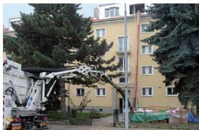
Stroj MTS DINO 3, který používá společnost HUTIRA - BRNO, s.r.o. při odsávání suti z podkrovních místností
