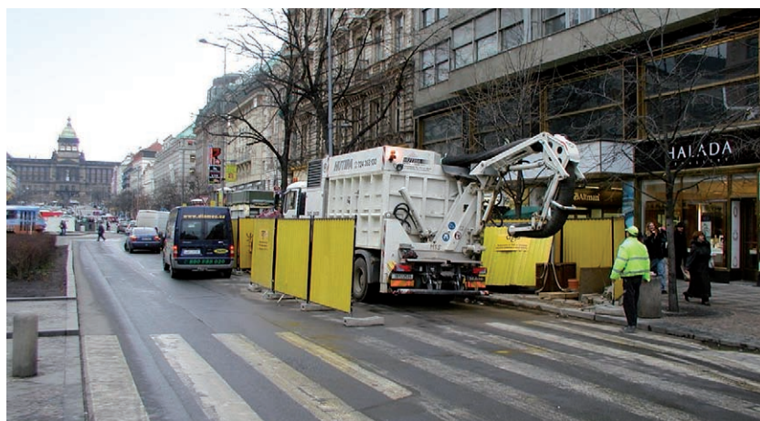
Zábor veřejného prostranství je nutný jen v průběhu technologických a odsávacích operací
