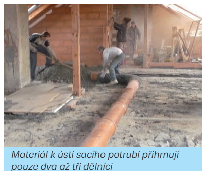
Nejdelší účinná vzdálenost odsávání materiálu je 80 m
